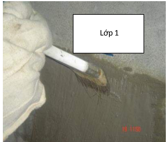
Thi công lớp thứ nhất
