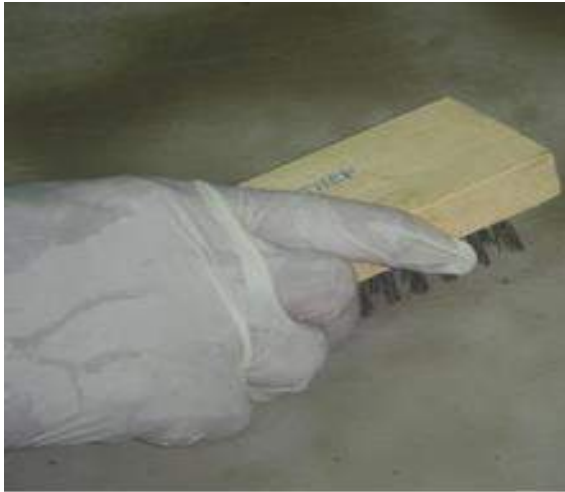
Vệ sinh bề mặt
