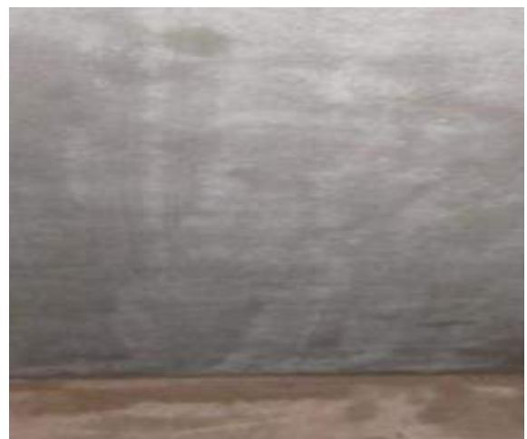
Bề mặt hoàn thiện
