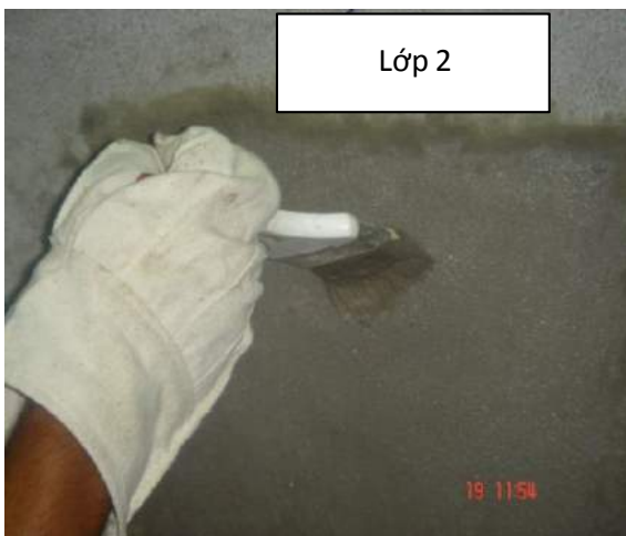
Thi công lớp thứ hai
