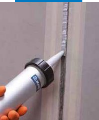
Thi công Mapeflex PU40
