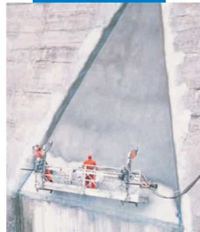
Hình ảnh Mapelastic được thi công chống thấm cho đập bằng phương pháp phun
