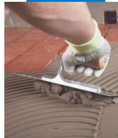
Thi công Granirapid lên sàn thượng đã được chống thấm bằng Mapelastic
