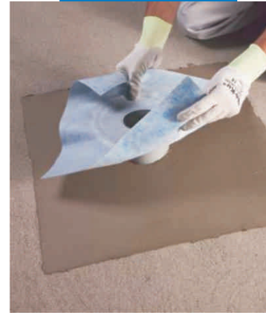
Lắp đặt ống dẫn nước trên Mapelastic
