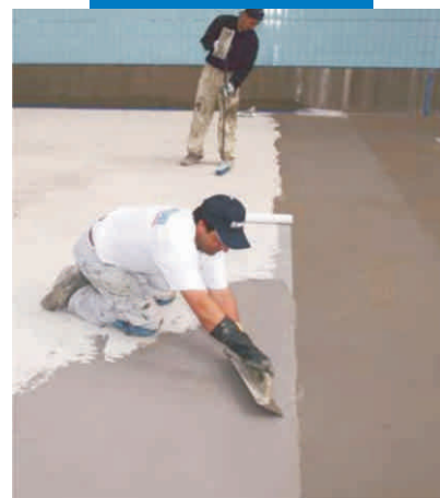
Chống thấm cho bể bơi sử dụng Mapelastick
