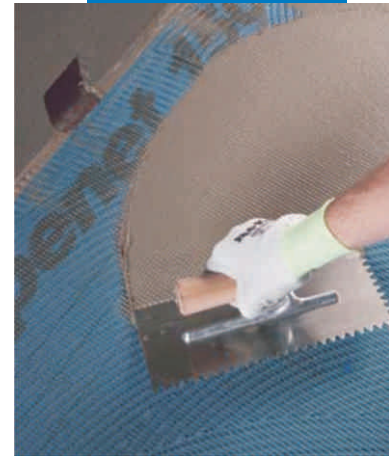
Thi công Mapelastic trên Mapenet 150
