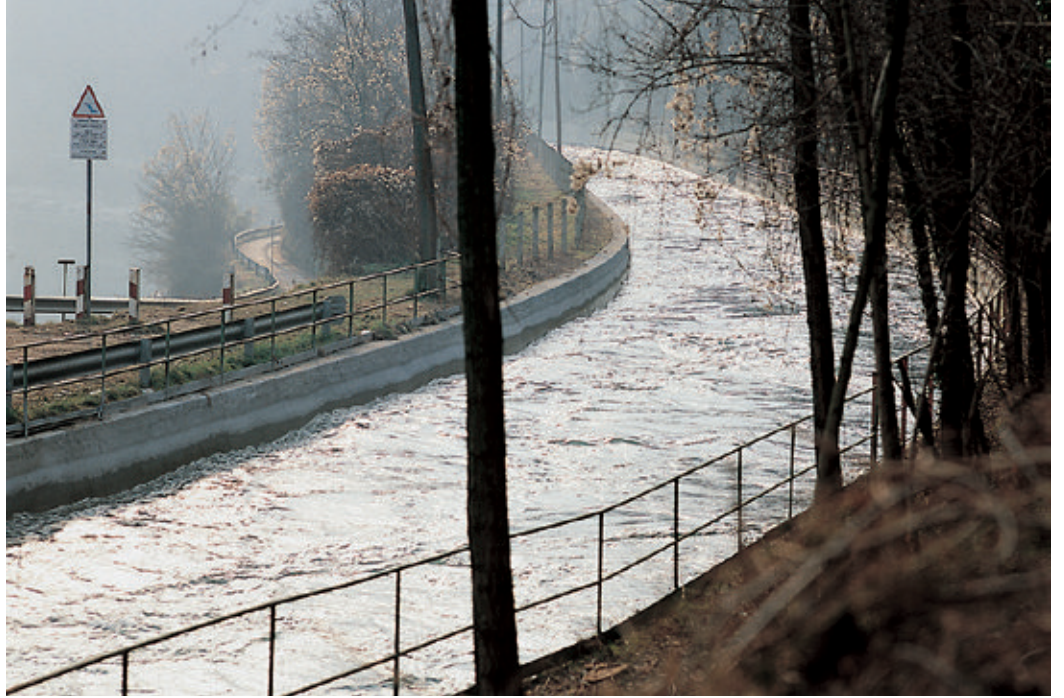
Kênh thủy điện Bertini - Commo - Ý. Bề mặt được xử lý bằng Planiseal 88
