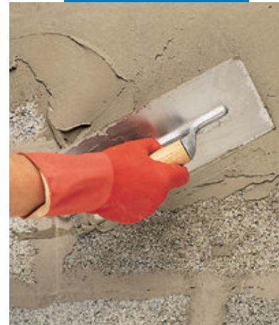
Thi công Planiseal 88 bằng bay
