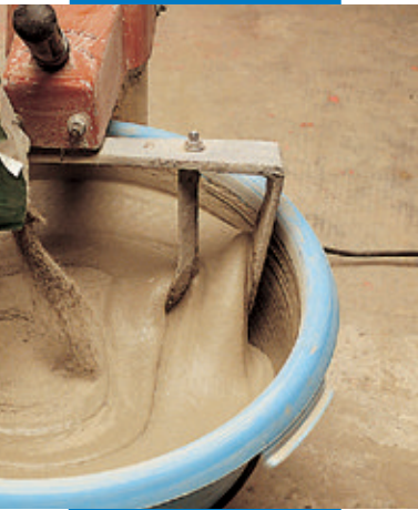
Planiseal 88 màu xám được trộn với nước
