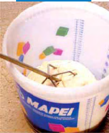
Trộn Mapeset bằng máy trộn cơ học
