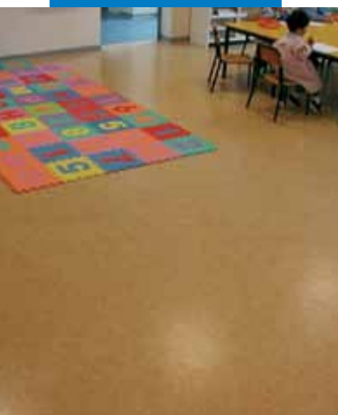
Sàn vải linoleum được trải trên sàn vừa tự san phẳng Ultraplan Eco - Trường mầm non Mirabello - Cantù (Como) - Ý
