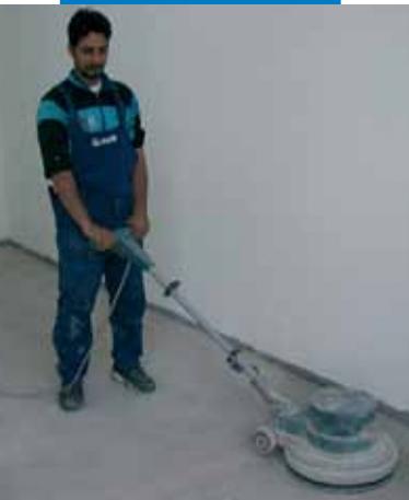
Đánh bóng sàn bằng máy trước khi thi công Ultraplan Eco - Trường mầm non Mirabello - Cantù (Como) - Ý
